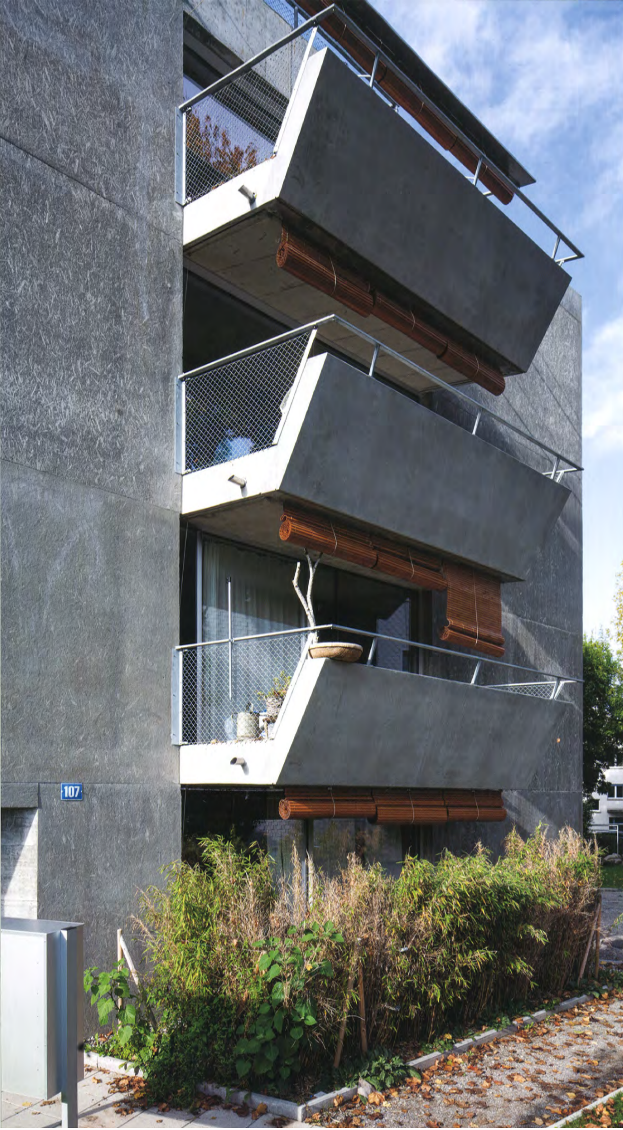
Partial east elevation with popping-out balconies 突き出たバルコニーが重なる東面
