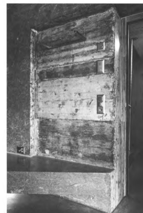
Flat A, third floor. Entrance. Concrete fixture unit of bench, shelf and coat hanging 4階, フラットA。玄関 ベンチ、棚、コート掛けが一体となったコンクリートの造作
